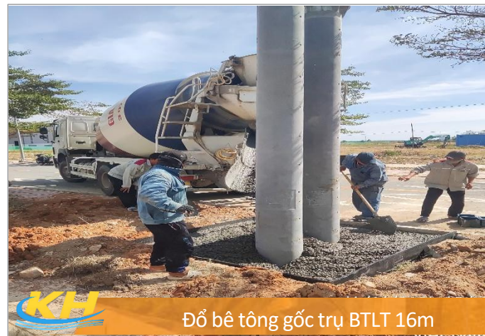
Dựng gốc trụ vị trí trạm biến áp
