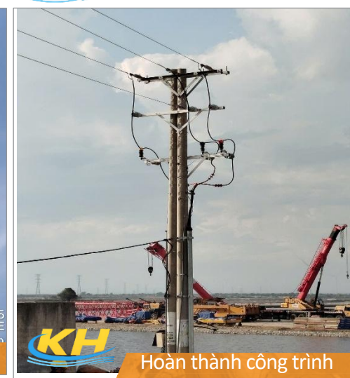
Lắp đặt đà, sứ, kéo rải dây
