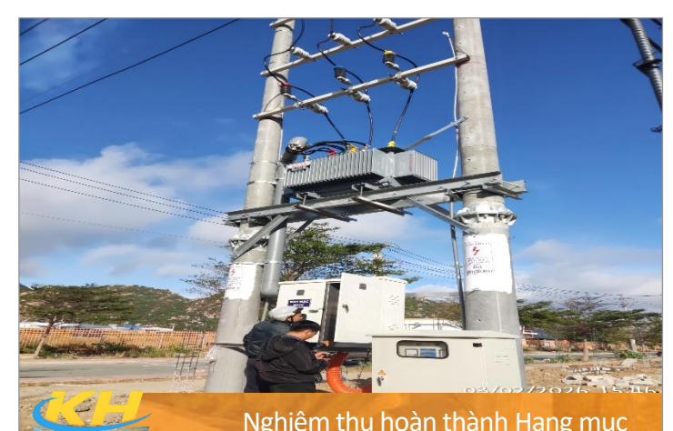
Hoàn thiện Hạng mục công trình
