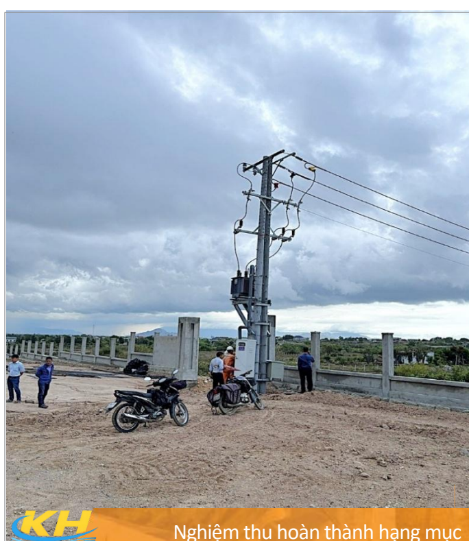
Lắp đặt đà sứ và đi dây trung áp
